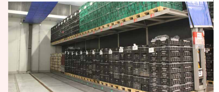
De rijdende platformen worden gevuld met vers aangevoerd plantgoed. Daarna worden ze in de doorstroomcel voor de aanzuigopening geplaatst. Dankzij de blauwe sleepdoek wordt de lucht uit de koelcel door de kisten aangezogen en de warmte van het plantgoed afgevoerd.
